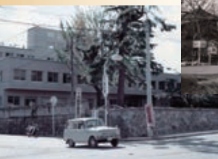
鉄筋コンクリートに改築後
